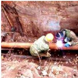
Интенсивный износ сетей горячего, холодного водоснабжения и теплоснабжения из низкоуглеродистой стали, низкое качество строительно-монтажных работ приводят к прорывам трубопроводов и утечкам. Возникает проблема ремонта повреждений в кратчайшие сроки и с надлежащим качеством.
